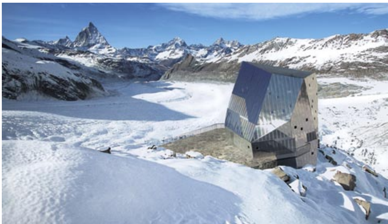
Das autarke Gebäude der von der ETHZ projektierten Monte-Rosa-Hütte in seiner grandiosen Extrem-lage über dem Grenz-gletscher
